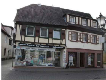
Negativbeispiel für eine Fassadengestaltung
