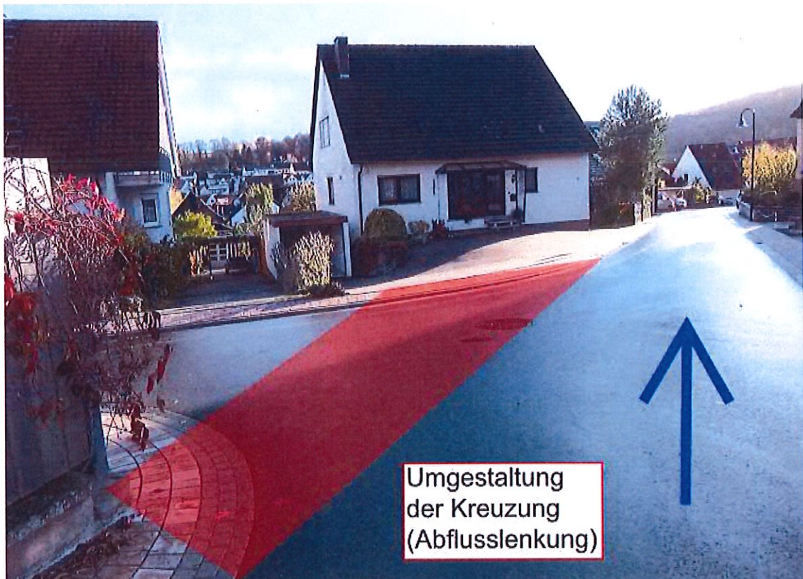
Abbildung 53: Notabflussweg; Kreuzungsbereich Dagobertstraße/In den Schelmengärten
