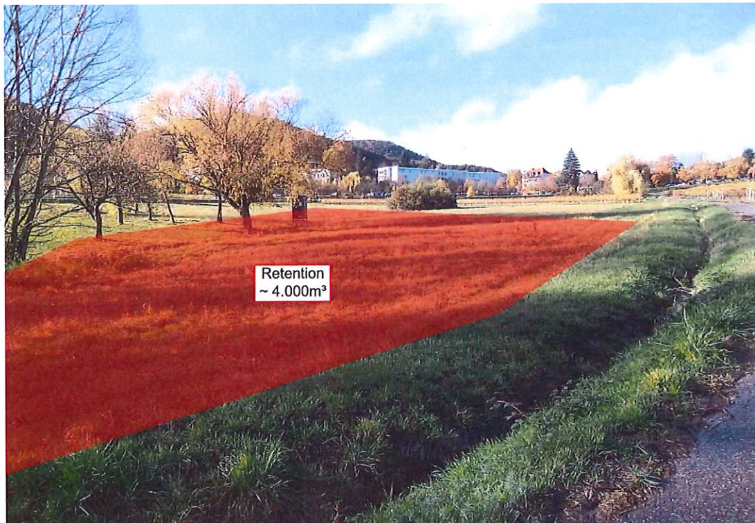
Abbildung 59: Retentionsraum oberhalb von Klingenstein (Klinik)
