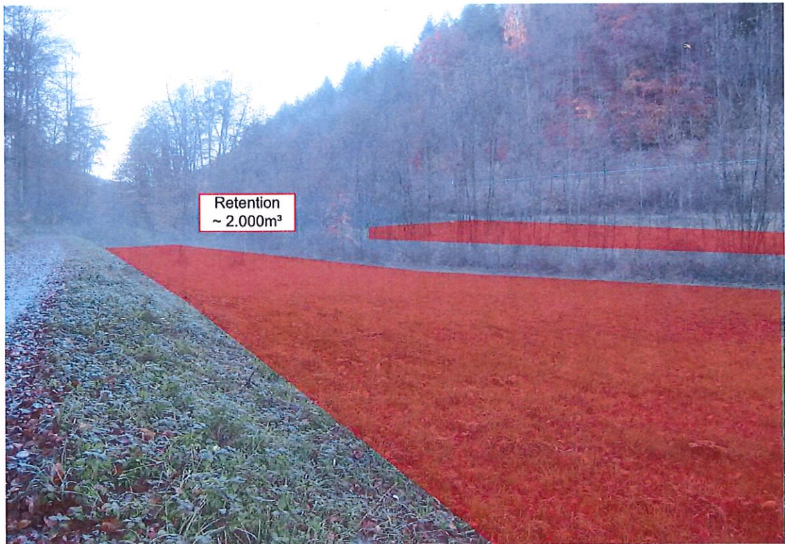
Abbildung 50: Retentionsraum westlich von Klingmünster
