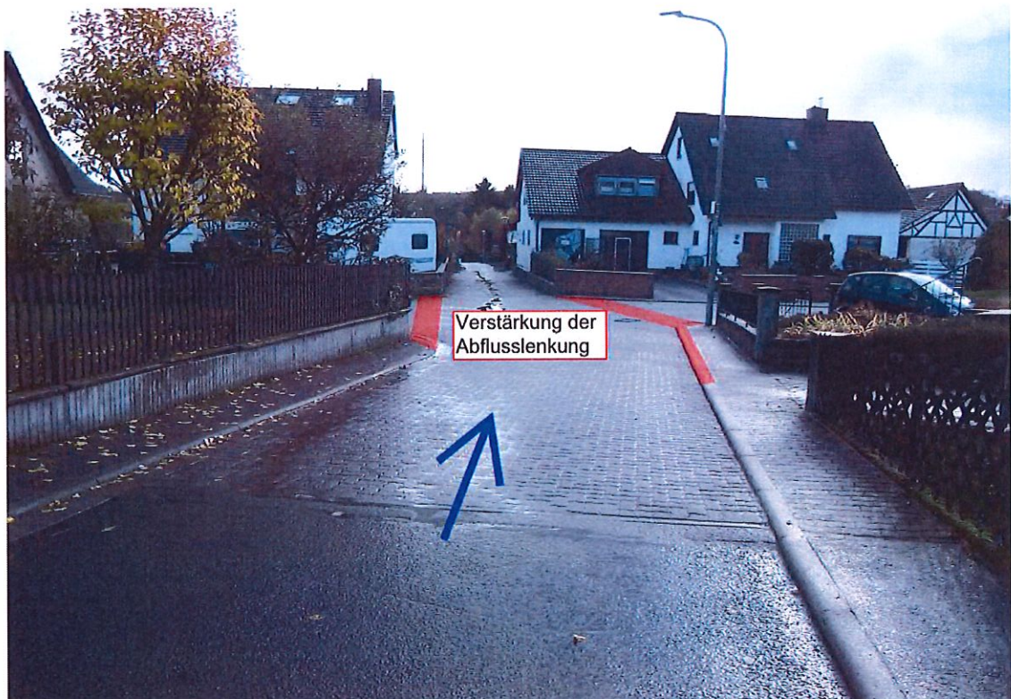
Abbildung 55: Notabflussweg; Kreuzungsbereich Im Kahngarten/Lettgasse
