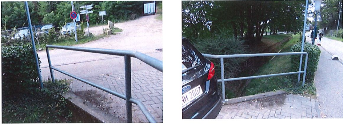
Abbildung 36: Grabensystem im Bereich der Klinik
