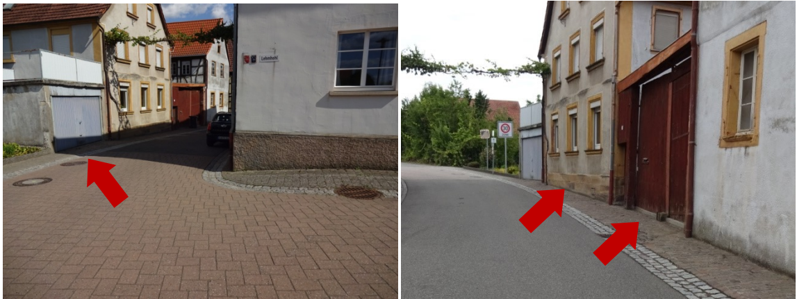
Fotos: tiefliegende Garagenzufahrt, Hofzufahrt und Kellerfenster im Bereich Jahnstraße Nr. 6
