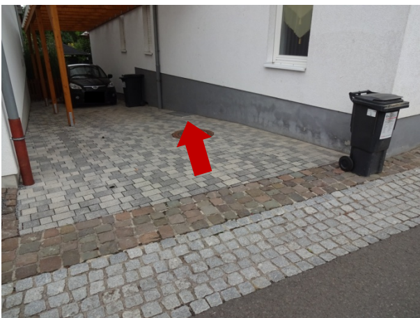
Foto: tiefliegendes Kellerfenster bei Hauptstraße Nr. 34
