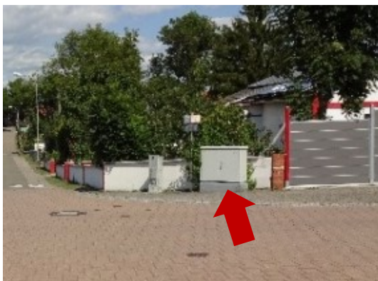
Foto: Infrastruktur Strom; Kreuzungsbereich Jahnstraße/Mühlweg
