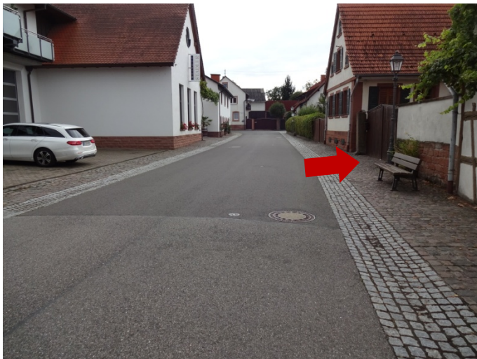
Foto: tiefliegende Hofeinfahrt Hauptstraße Nr. 56
