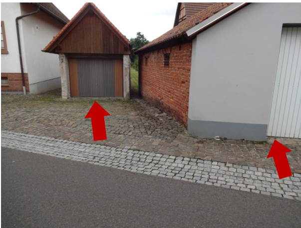
Fotos: tiefliegende Garagenzufahrten zwischen Hauptstraße Nr. 36 und 38
