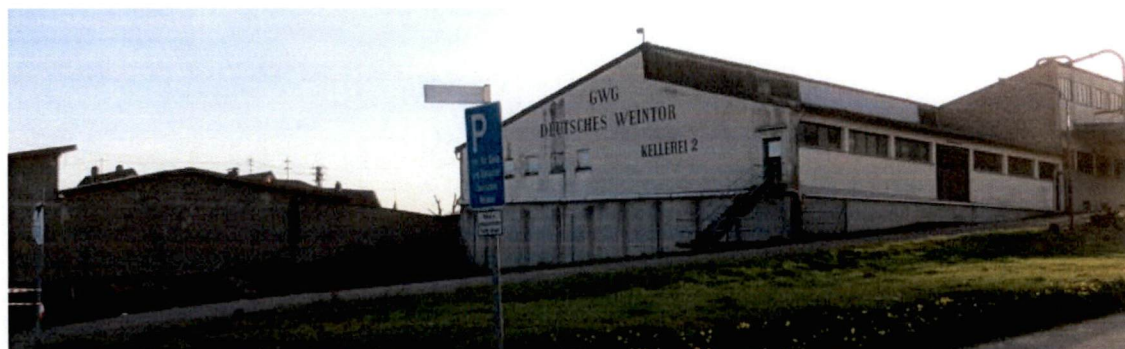
Bild 3: Platzansicht des Kellereigebäudes
