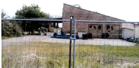
Bild 4: Westansicht des Kellereigebäudes
