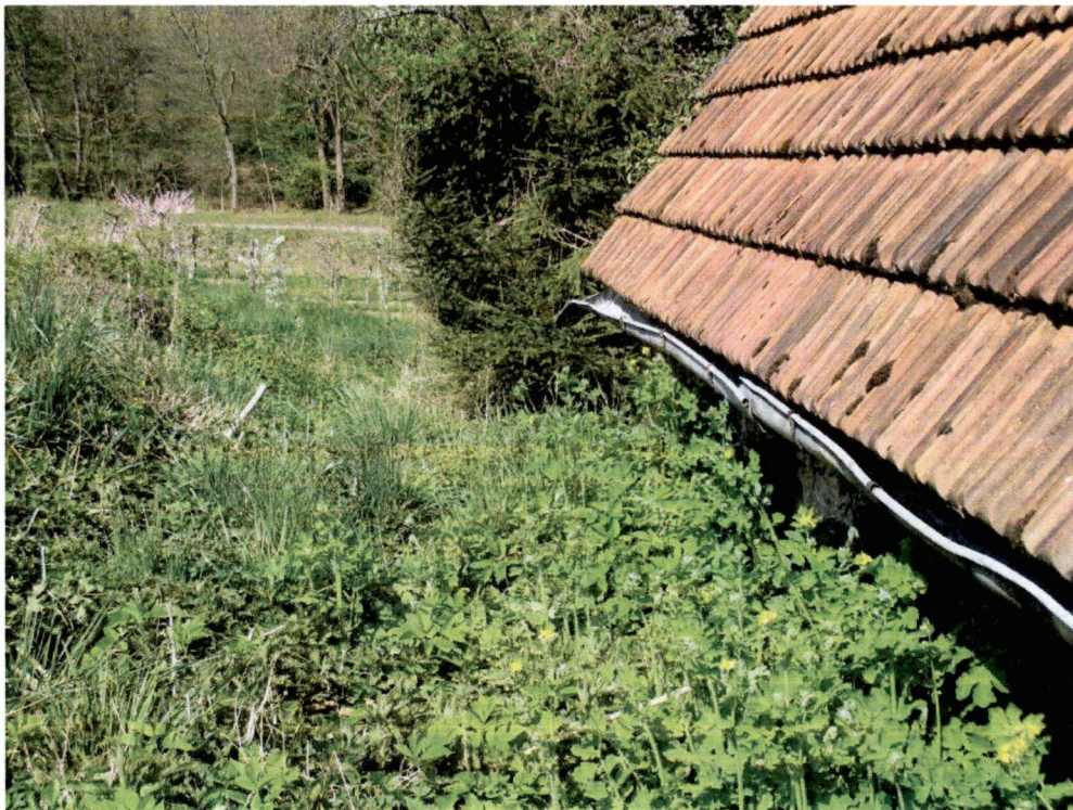
Abb. 4: nördlich angrenzende, in den Hang gebaute Scheune; Blick nach NW
