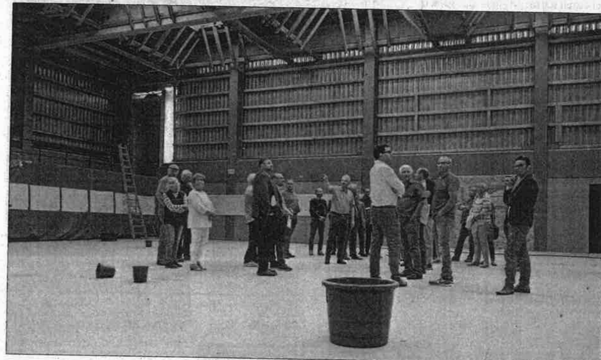
Tropf, Tropf, die Mitglieder des Bau- und des Hauptausschusses sehen sich die entkernte VG-Halle an, in der es seit Jahren durch die Luken in der Decke regnet, deshalb die Bottiche und Eimer am Boden.
