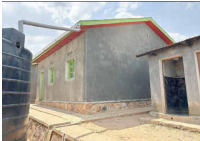
Eines der Häuser für Familien, deren Bau über Projekte des Ruandaverbands SÜW unlängst unterstützt wurde.
